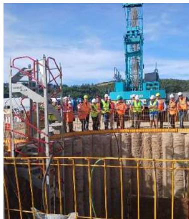
Poursuite des travaux de renouvellement du réseau gazier avec creusement d'un puit d'entrée de 25 m de diamètre sur 9 m de profondeur pour microtunnelage à 8m de profondeur sous le Tarn
